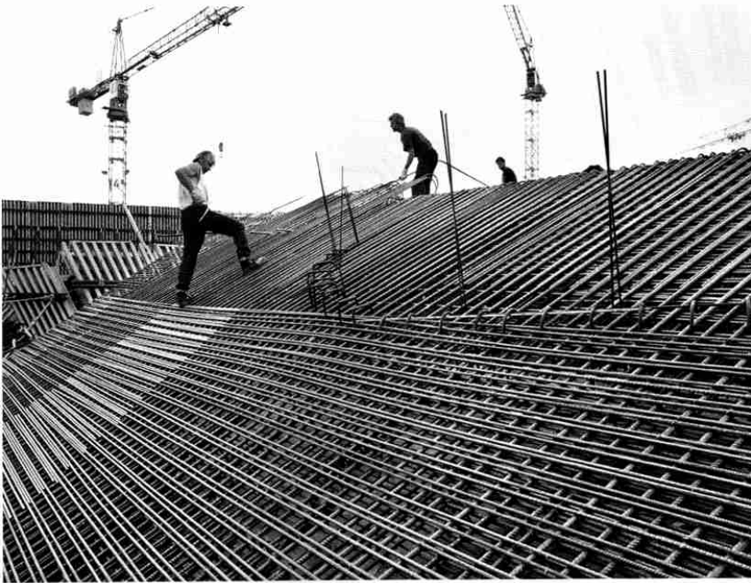
Die Bewehrungsdichte und die Schrägen der Konen erforderten die Entwicklung eines Betons, der sich selbst verdichtet. Der runde Anschluss von den Konen zur Rippendecke verlangt höchste Präzision im Schalungsbau und Eile bei der Einbringung des Betons. Die Lage der Armierung lässt die zukünftige Form der Sichtbetonfläche bereits erahnen.
